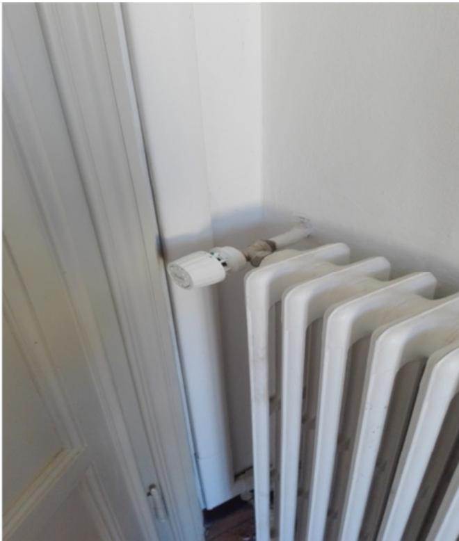
Valvole termostatiche installate sui singoli corpi scaldanti.
